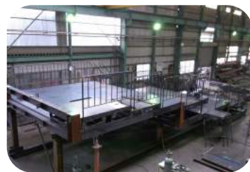
プラント鉄骨
