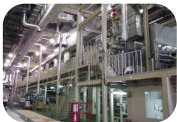
プラント鉄骨
