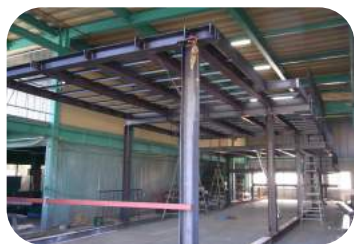
プラント鉄骨
